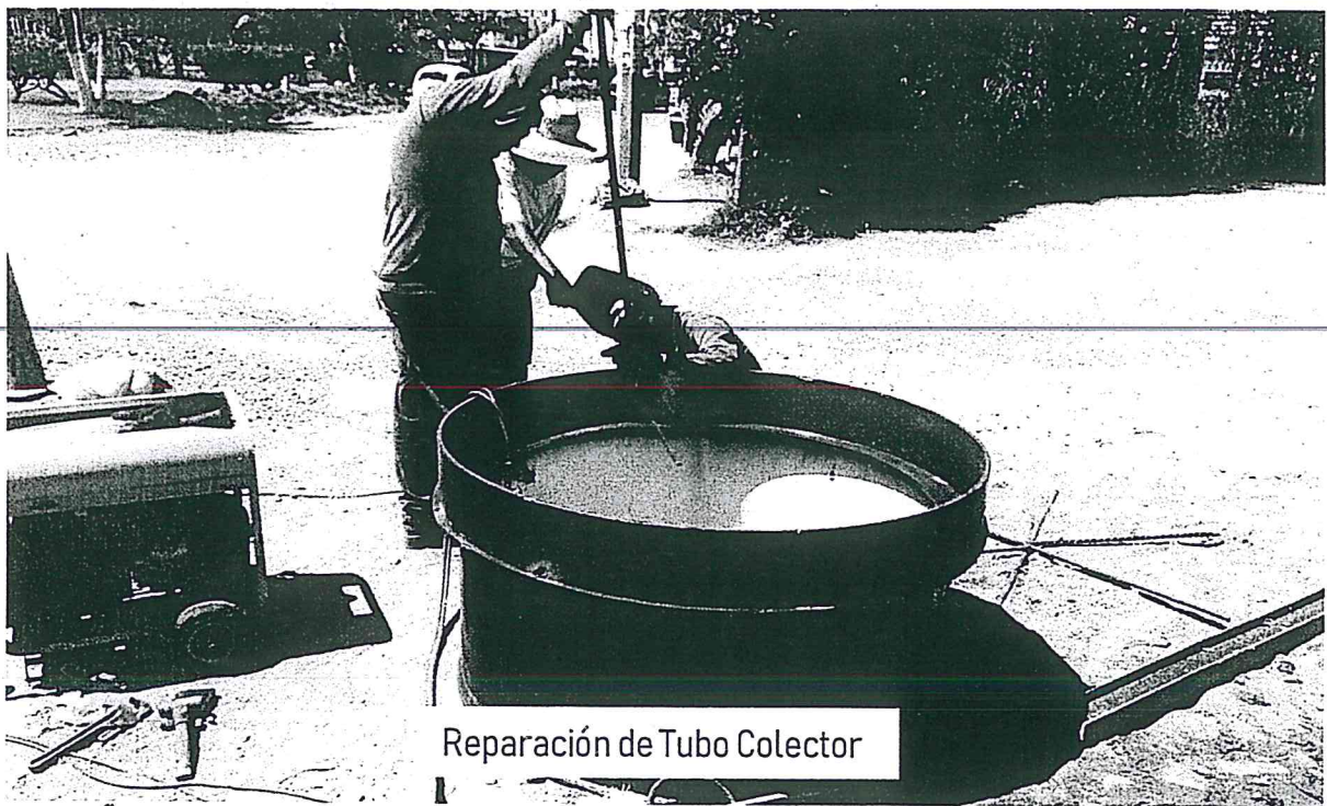
Reparación de Tubo Colector
